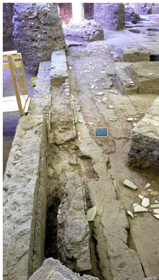
Fig. 82. Ambiente IV. Angolo sud-occidentale con interventi di II fase: basi per statue, banchina, rifodera del muro occidentale e rialzamento del pavimento. Sul pavimento residui della spoliatura dei rivestimenti e trincea di spoliazione, da sud. Foto di O. Menghi, febbraio 2007.
