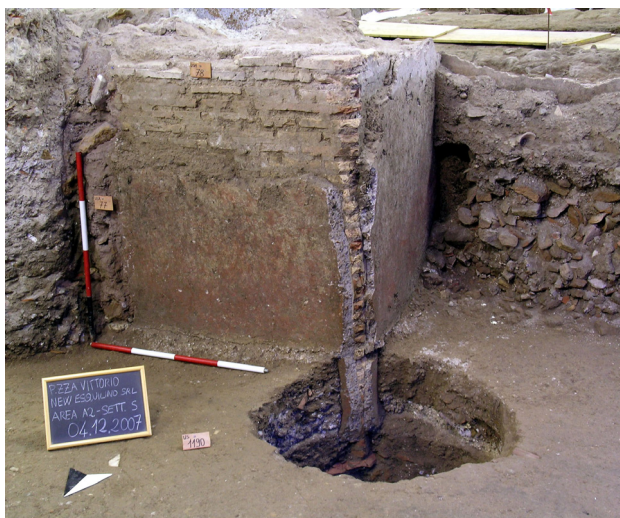
Fig. 85. Area A2. Pilastro in laterizio intonacato a ridosso dell'ambiente IV, da nord. In basso, perforazione non autorizzata. Foto di S. Barrano, dicembre 2007.
