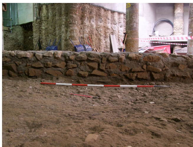
Fig. 34. Area Cortile Grande. Parete occidentale del muro in opera cementizia di tufo con paramento in blocchetti irregolari, da ovest. Foto di S. Festuccia, agosto 2009.
